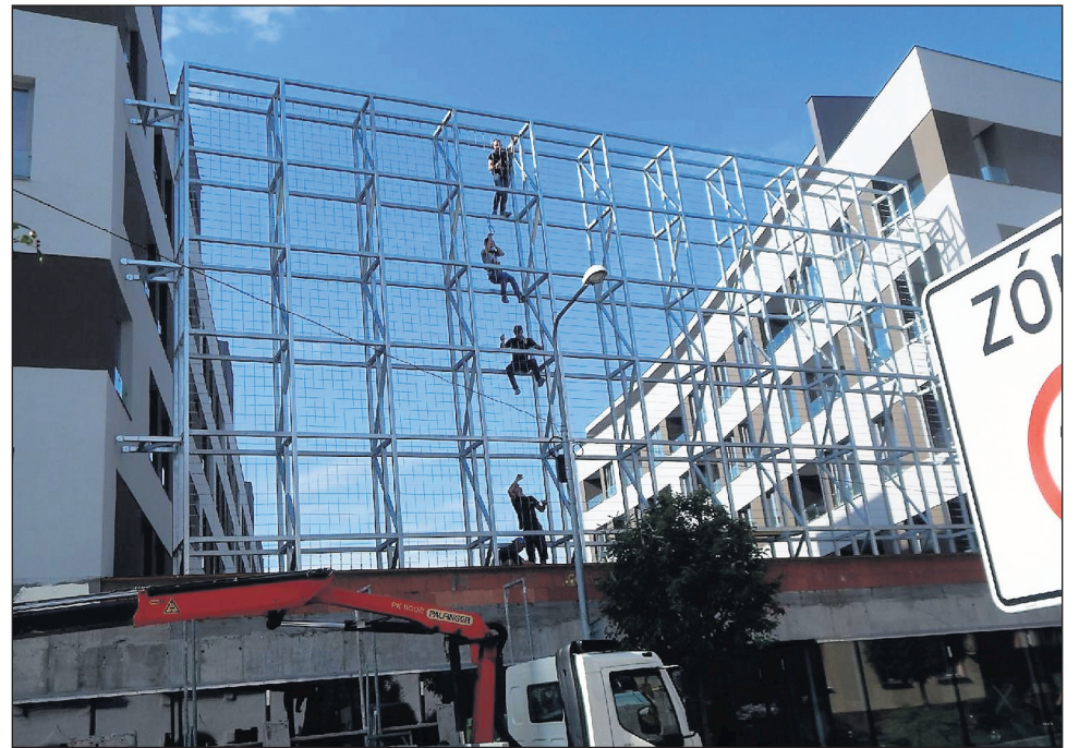
Pohled z Kmochovy ulice. Montáž konstrukce pro zelenou stěnu, která bude vyrůstat ze střechy 1. patra.
